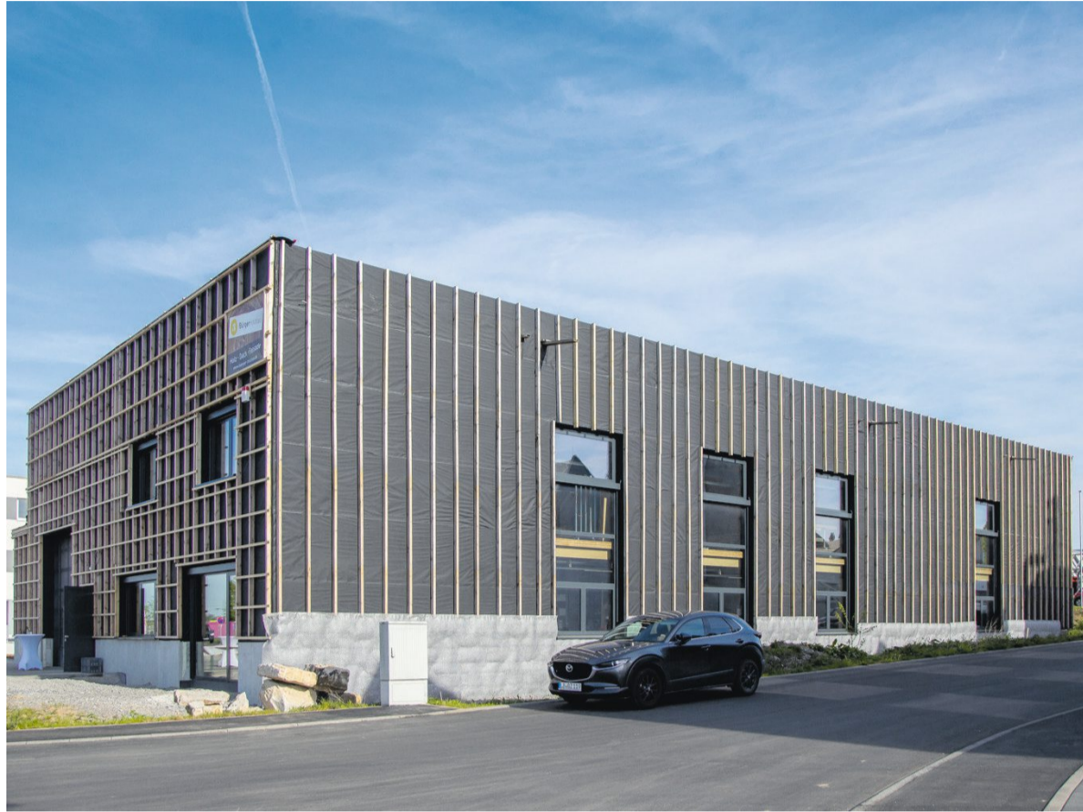
Die neue Halle von Bürger Holzbau GmbH wurde mit einem großen Fest eingeweiht. Fotos: Oliver Bürkle
