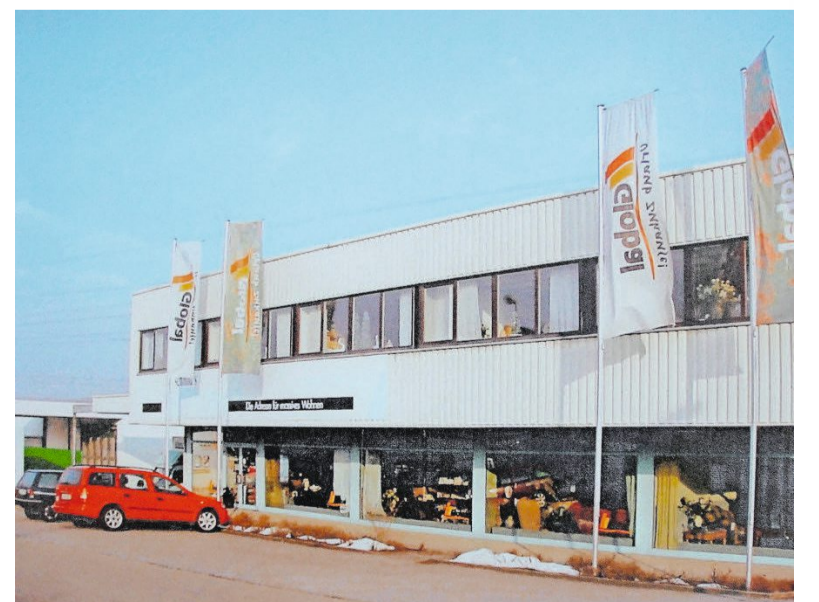
Nach sieben Monaten Bauzeit 1983 wurde der „Möbelladen“ in der Siemensstraße eröffnet.
