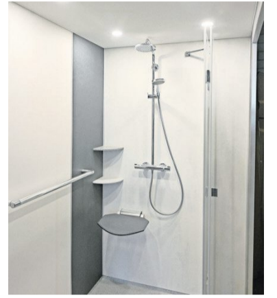
Duschen werden seniorengerecht in kürzester Zeit umgebaut.
