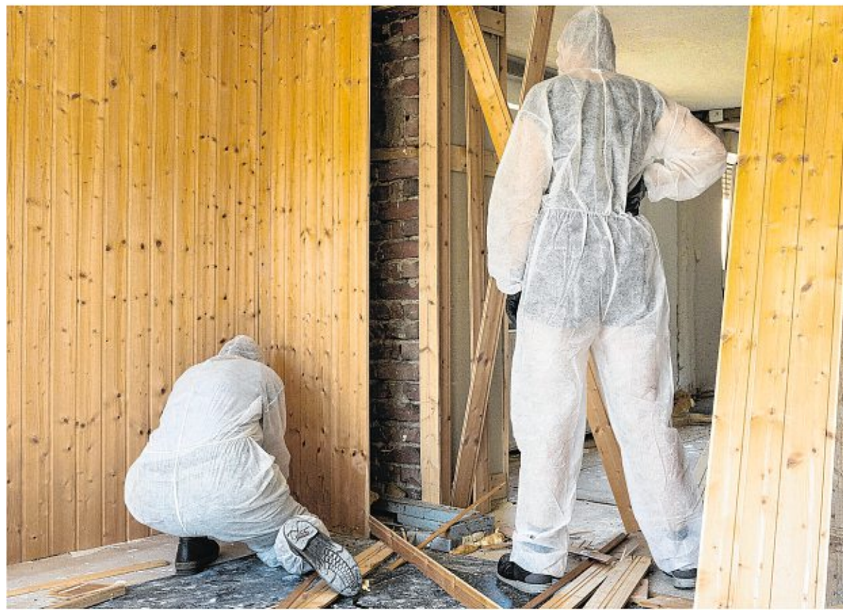
Sanieren oder abreißen? Eine alte Immobilie nach eigenen Wünschen neu zu gestalten, kann mit viel Aufwand und hohen Kosten verbunden sein: Foto: Florian Schuh/dpa-tmn/dpa
