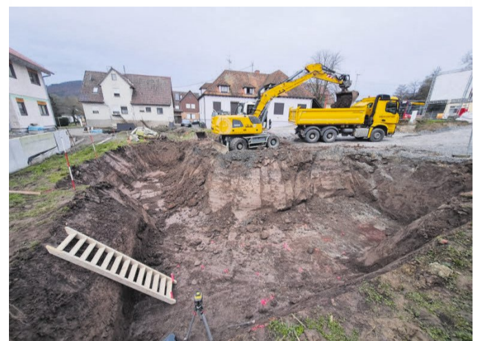
Der W.O.-Bagger ist in Hohenhaslach wieder am Start. Foto: Wohnbau Oberriexingen
