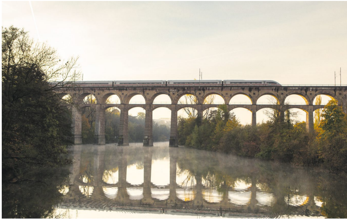
Das Bietigheimer Enzviadukt ist ein Wahrzeichen der Stadt Bietigheim.
