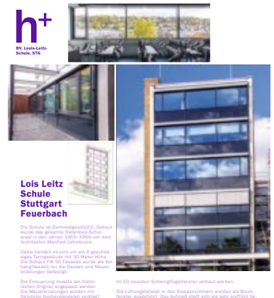
Denkmalgeschütztes Gebäude nach Ausführung der Arbeiten.
