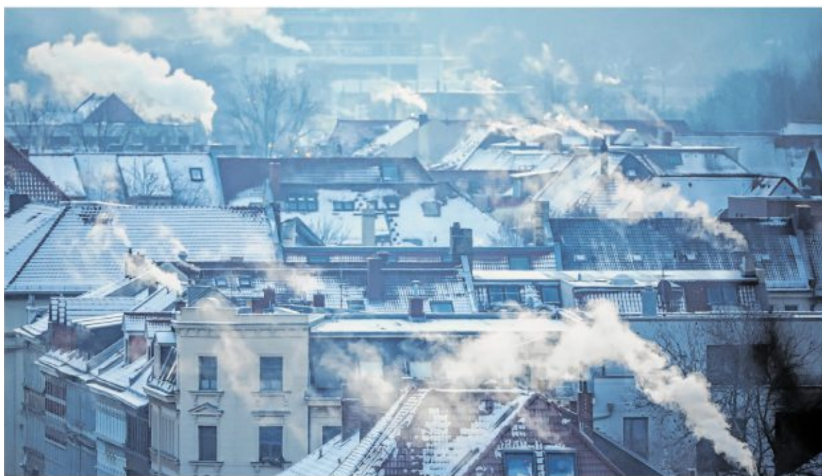
Dächer sind dem Wetter unmittelbar ausgesetzt und sind besonders anfällig für Schäden durch Feuchtigkeit und Frost. Fachleute erkennen am besten, wo Handlungsbedarf besteht. Foto: Jan Woitas/dpa-tmn
