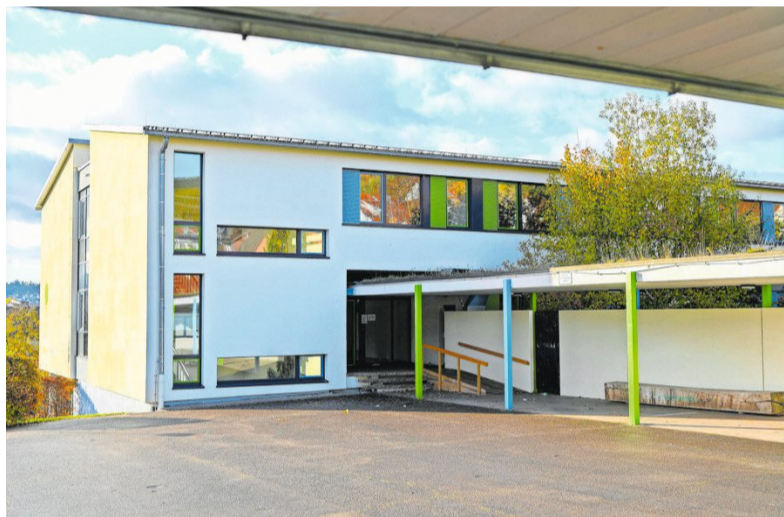
Der Schulbetrieb konnte ab dem neuen Schuljahr komplett in den umgebauten und sanierten Räumlichkeiten aufgenommen werden.
