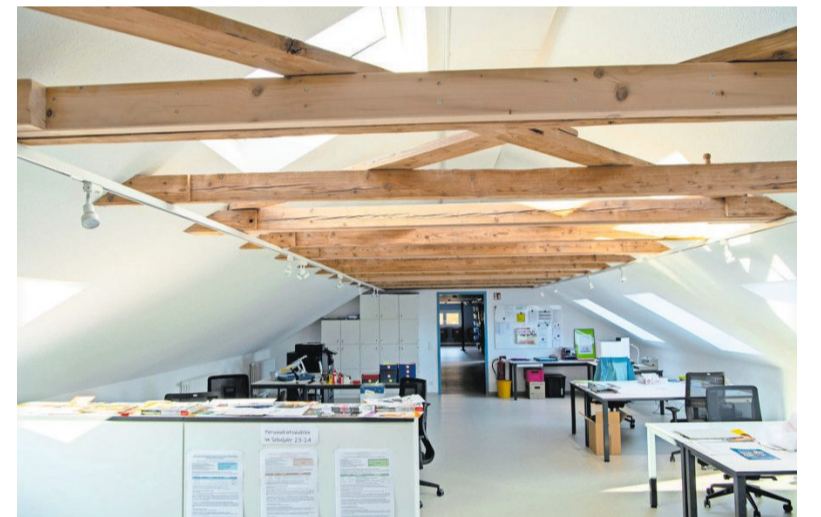
Im Altbauteil ist auf der Bühne ein neues Lehrerzimmer eingerichtet worden.
