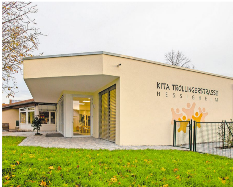
Der Erweiterungsbau wurde in Massivbauweise erstellt. Das Flachdach ist zur Aufnahme einer Fotovoltaikanlage vorbereitet.
