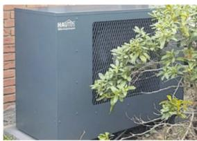
Luft-Sole-Tauscher als Wärmequelle für die Sole-Wasser-Wärmepumpe. Foto: HLC/Hautec
