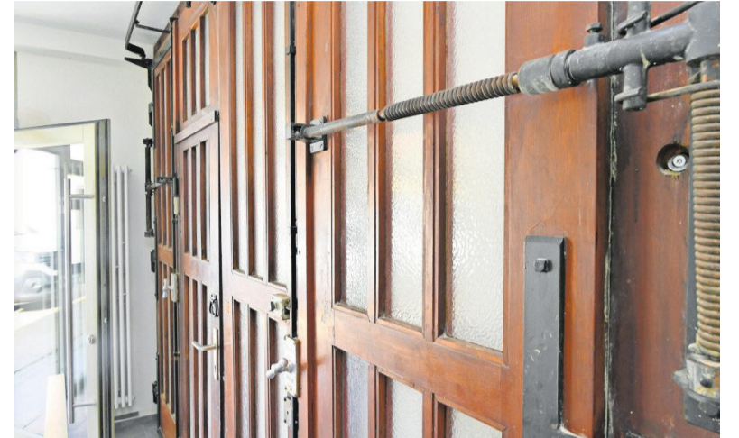
Die Tür der ehemaligen Feuerwehrräume stammt aus dem Jahr 1910 und schmückt nun die Wand des behindertengerechten Eingangs.
