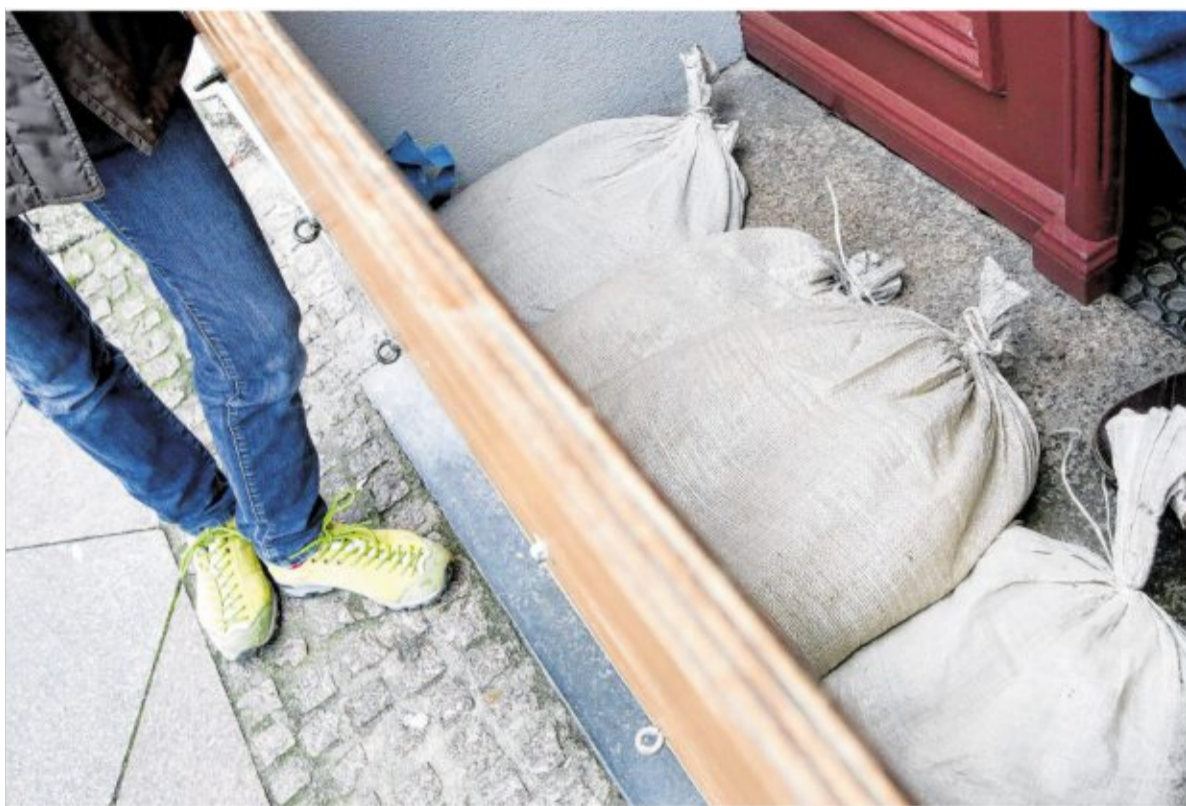
Sandsäcke können helfen, das Eindringen von Wasser ins Haus zu vermeiden oder zumindest zu verlangsamen. Auch Holzbretter und -platten leisten hier gute Dienste. Foto: Bodo Marks/dpa/dpa-tmn
