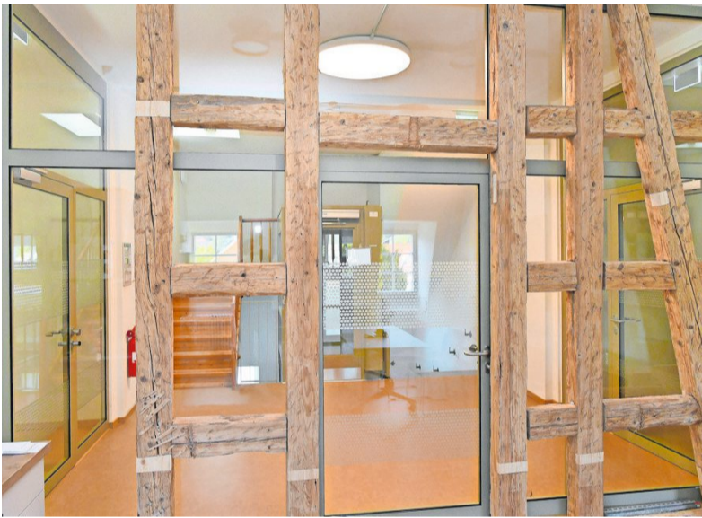
Teilweise wurden die alten Fachwerkbalken erhalten und in die moderne Architektur eingebunden.
