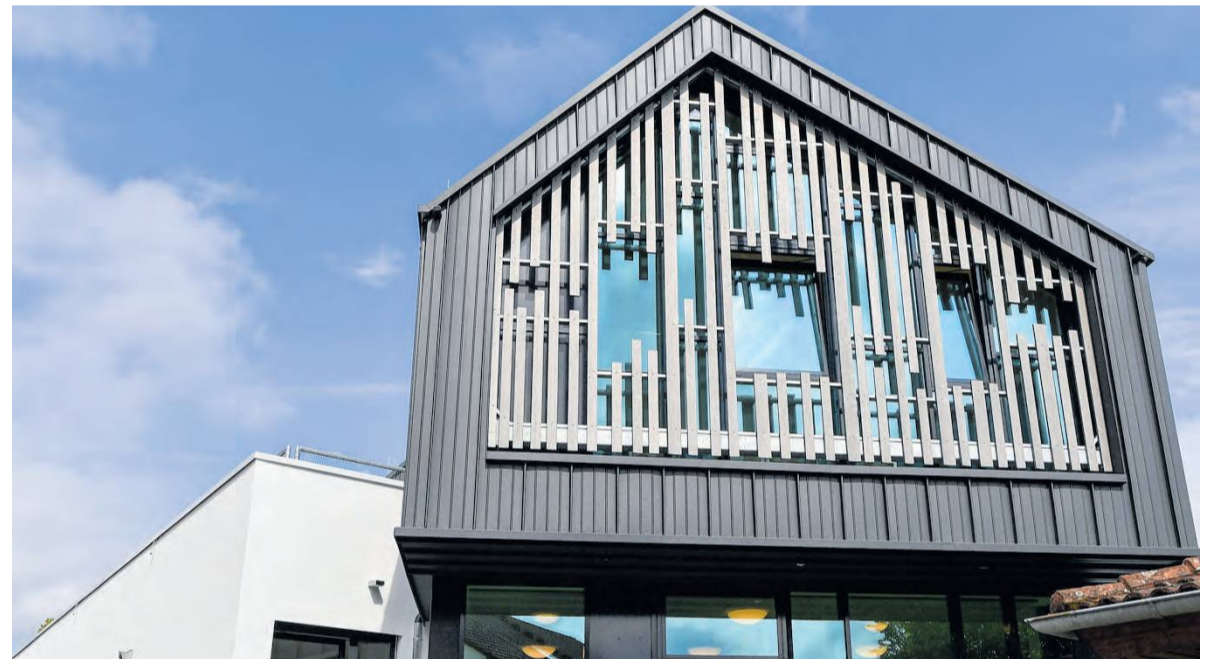
Die Außenfassade wurde architektonisch interessant in Holzoptik und mit aufgelockerten Durchbrüchen für viel Lichteinfall gestaltet. Foto: Martin Kalb
