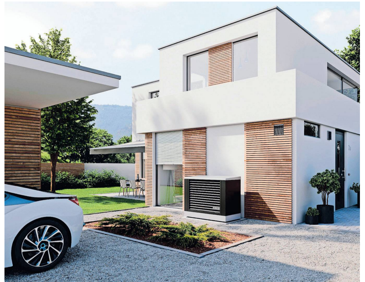
Angenehme Temperaturen zu jeder Jahreszeit versprechen Wärmepumpe und Fußbodenheizung.
