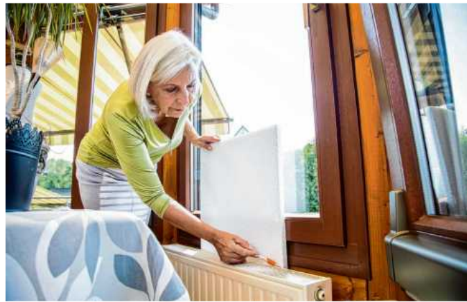
Auch Heimwerker können viele Arbeiten erledigen, die energiesparend wirken. Die Wand hinter einem Heizkörper etwa lässt sich mit Dämmstoffplatten isolieren, so geht weniger Heizwärme verloren.
