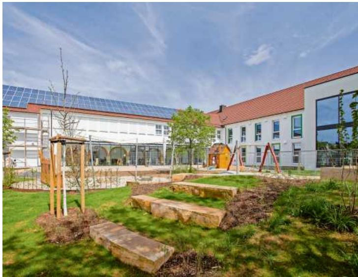
Das ehemalige Grundschulgebäude der Jakob-Löffler-Schule wurde innerhalb von zwei Jahren zum neuen Kindergarten umgebaut. Fotos: Oliver Bürkle
