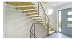
Eine freitragende Treppe. Foto: HLC/Kennigott
