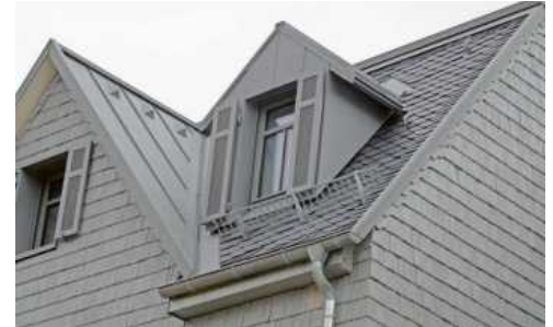
Blick auf das Dach von Haus Ost: Es ist als Satteldach mit Giebel und Gauben ausgeführt und mit Schiefer gedeckt.
