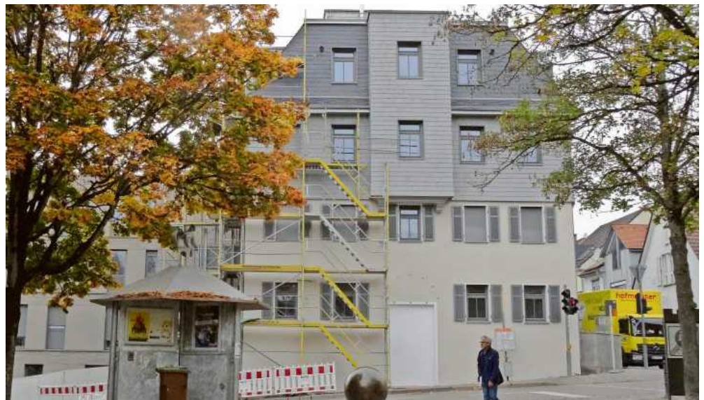
Die selbe Blickrichtung, das neue Gebäude: über der weißen Türfläche sind die vorbereiteten Löcher für das Vordach zu sehen. Der linke Teil des Hauses ist noch eingerüstet, hier laufen noch Restarbeiten.
