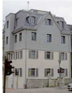
Blick aus Richtung Hillersschule auf Haus Ost.
