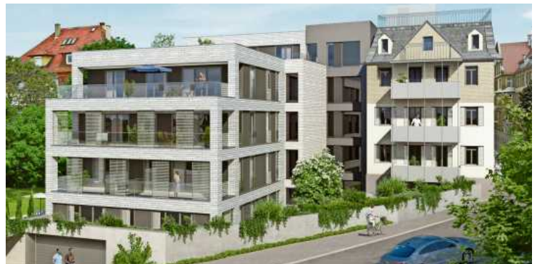
Gesamtansicht (Visualisierung): links Haus West, rechts Haus Ost, an dem derzeit noch die letzten Arbeiten erledigt werden.
