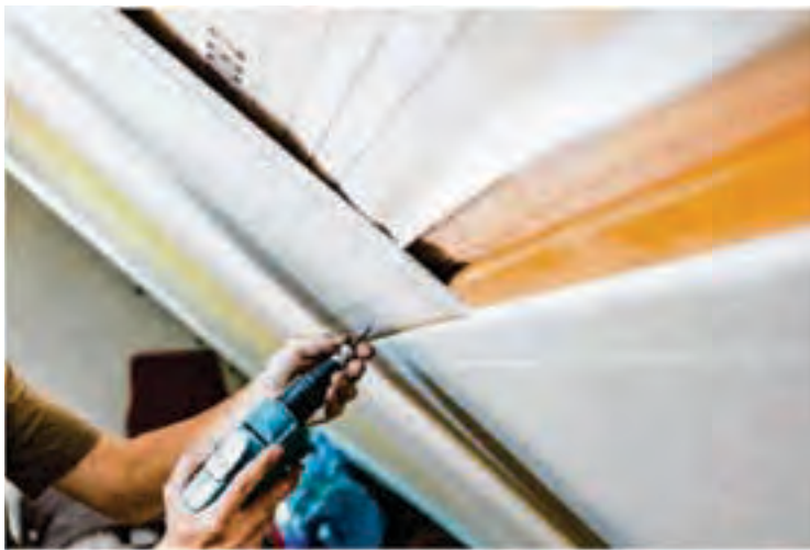
Gerade bei der Dämmung des Daches ist große Sorgfalt angesagt.
