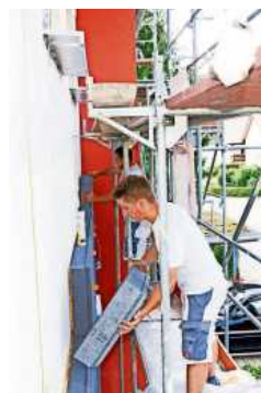
Stuckateure sind Spezialisten für die Dämmung von Gebäuden.
