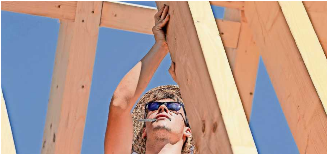
Zimmerer bei der Arbeit: Die Auftragsbücher der Innungsmittglieder sind gut gefüllt.
