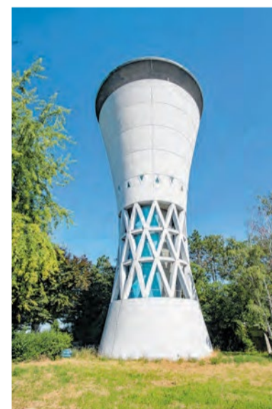
Das Wahrzeichen Möglingens: der Wasserturm.
