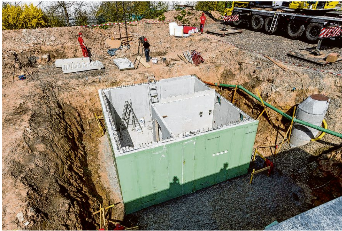
Ein Modulkeller muss nicht unbedingt unter dem Haus versenkt werden. Die Boxen können auch nachträglich an einer passenden Stelle vergraben werden. Foto: GÜF/Glatthaar Keller/dpa-tmn
