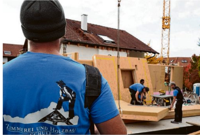
Per Fernsteuerung werden mit dem Kran schwere Lasten bewegt.
