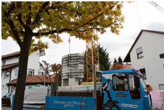
Der Betrieb ist vorwiegend in den Bereichen Sanierung, Dachsanierung, Neubau und Umbauten tätig.
