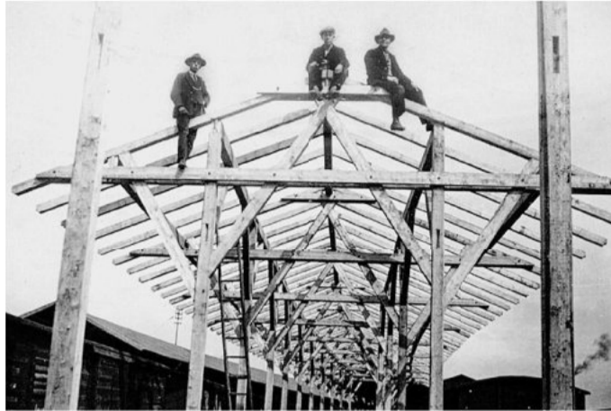
Die undatierte Aufnahme zeigt Zimmerleute beim Bau eines Dachstuhls.
