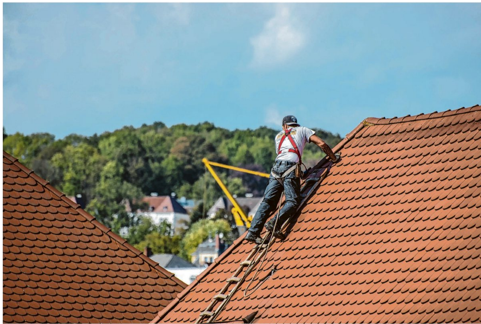
Dachdecker bei der Arbeit: Bevor in eine neue Heizung investiert wird, sollte zuerst die Gebäudehülle energetisch optimiert werden, so der Tipp der Dachdeckerinnung Stuttgart.
