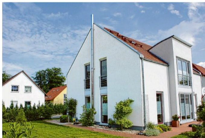
Seit Januar 2022 muss die Mündung eines neu errichteten bzw. nachträglich gebauten Schornsteins den Dachfirst um mindestens 40 Zentimeter überragen.
