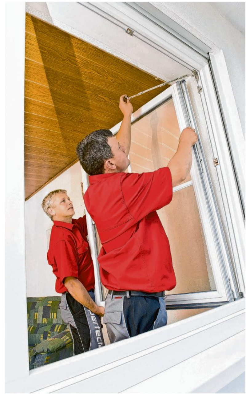
Ein spezielles Montagesystem ermöglicht den „Fensterwechsel ohne Dreck“. So muss niemand Schmutz und Staub oder gar beschädigte Tapeten, Fliesen und Bodenbeläge fürchten, wenn er seine Fenster austauscht. Foto: HLC/perfecta
