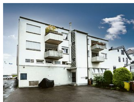
Bietigheim-Bissingen | MFH mit Gewerbe
