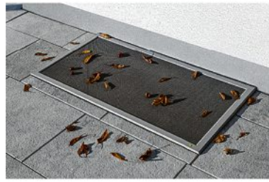
Mit Lichtschachtabdeckungen haben Laub, Dreck und Kleintiere keine Chance, in die Kellerräume zu gelangen. Foto: HLC/Neher
