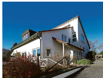
Freiberg a. N. | Einfamilienhaus
