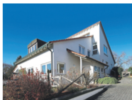
Freiberg a. N. | Einfamilienhaus
