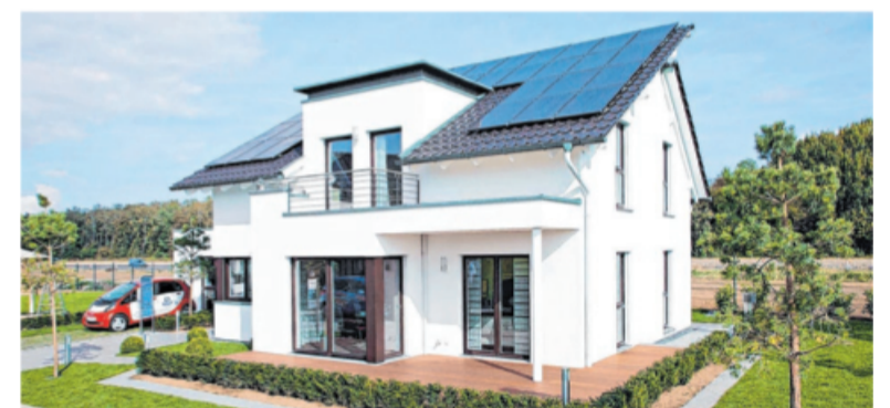
Energieeffizienz von vornherein mitgedacht: ein Vorteil von Neubauten. Foto: WeberHaus
