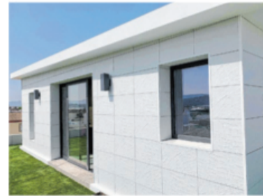
FOTO: HLC/ZIERER FASSADEN
