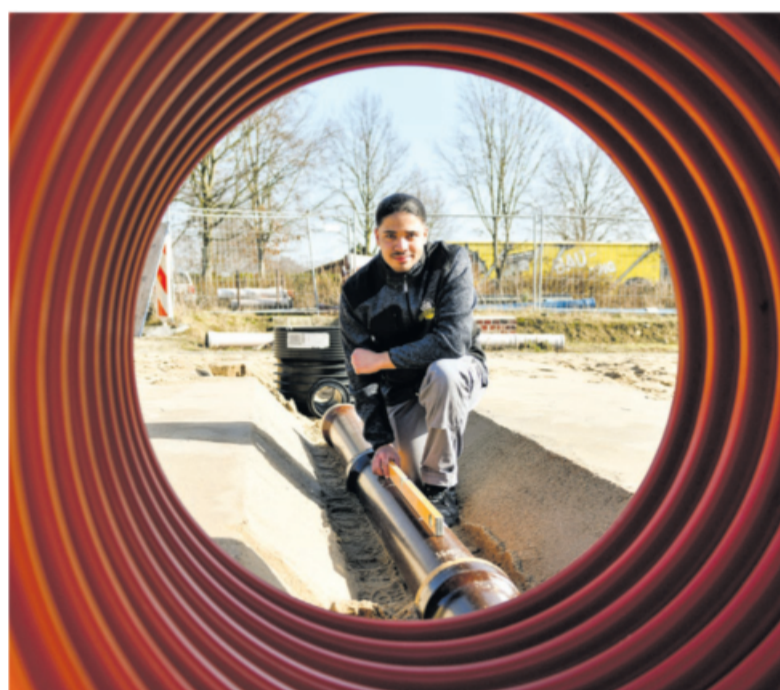
„Ohne den Kanalbauer geht es nicht“: Der Auszubildende Issam Bhihi schätzt an seinem Beruf nicht zuletzt die Abwechslung. Der Schwerpunkt der Arbeiten liegt im Tiefbau. Foto: Kirsten Neumann / dpa-tmn
