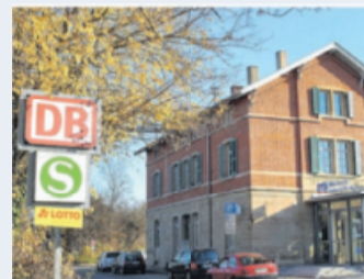
Derzeit werden am Freiberg-Bahnhof die Aufzüge ausgetauscht.
