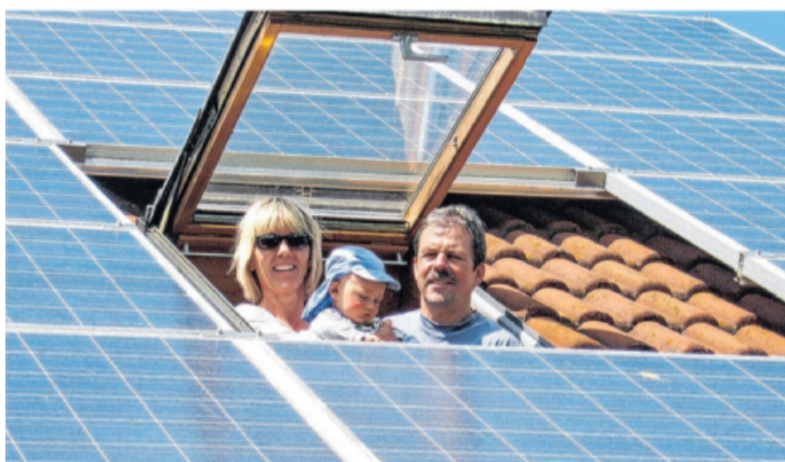
Solarstrom-Anlage mit Solarspeicher zur optimierten Eigennutzung. Das freut die Familienkasse und das Klima.
