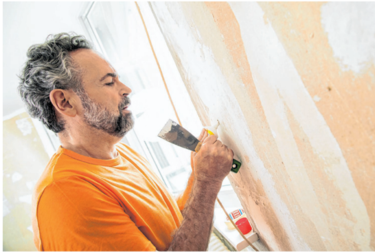
Bohrlöcher lassen sich gut schließen, indem man Spachtelmasse in die Maueröffnungen einarbeitet. Die Masse kann im passenden Farbton eingefärbt werden. Foto: Christin Klose/dpa
