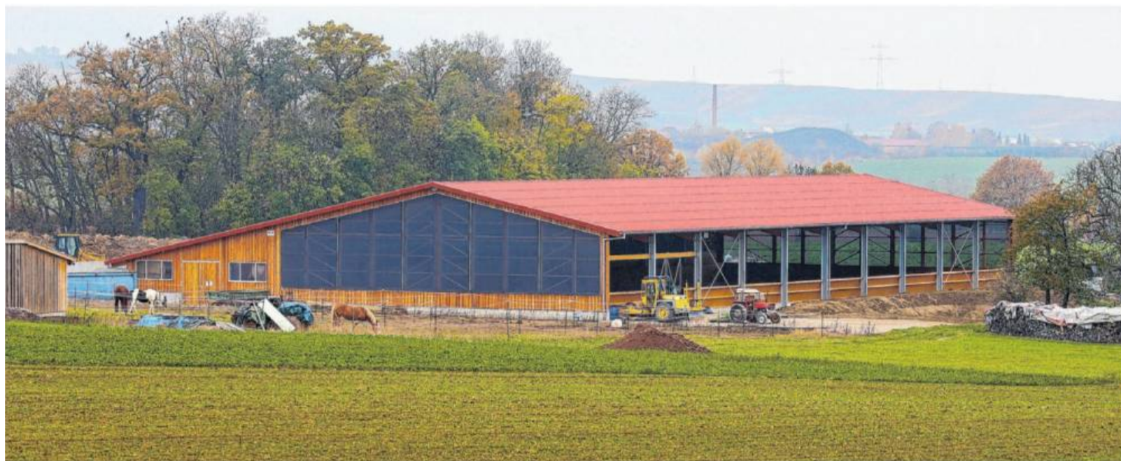
Die neue Reitanlage des Reit- und Fahrvereins Bönningheim u.U. e.V. misst 60 Meter mal 23 Meter.
