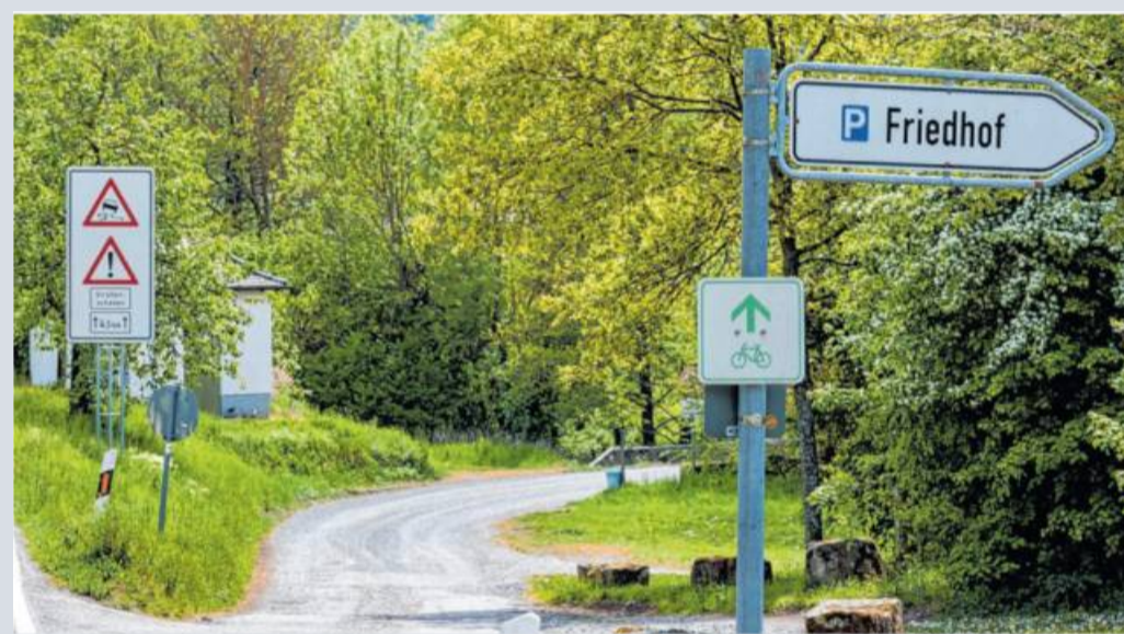
Es geht voran: Der Radweg zwischen Häfnerhaslach und Kirbachhof nimmt allmählich Gestalt an. Foto: Helmut Pangerl
