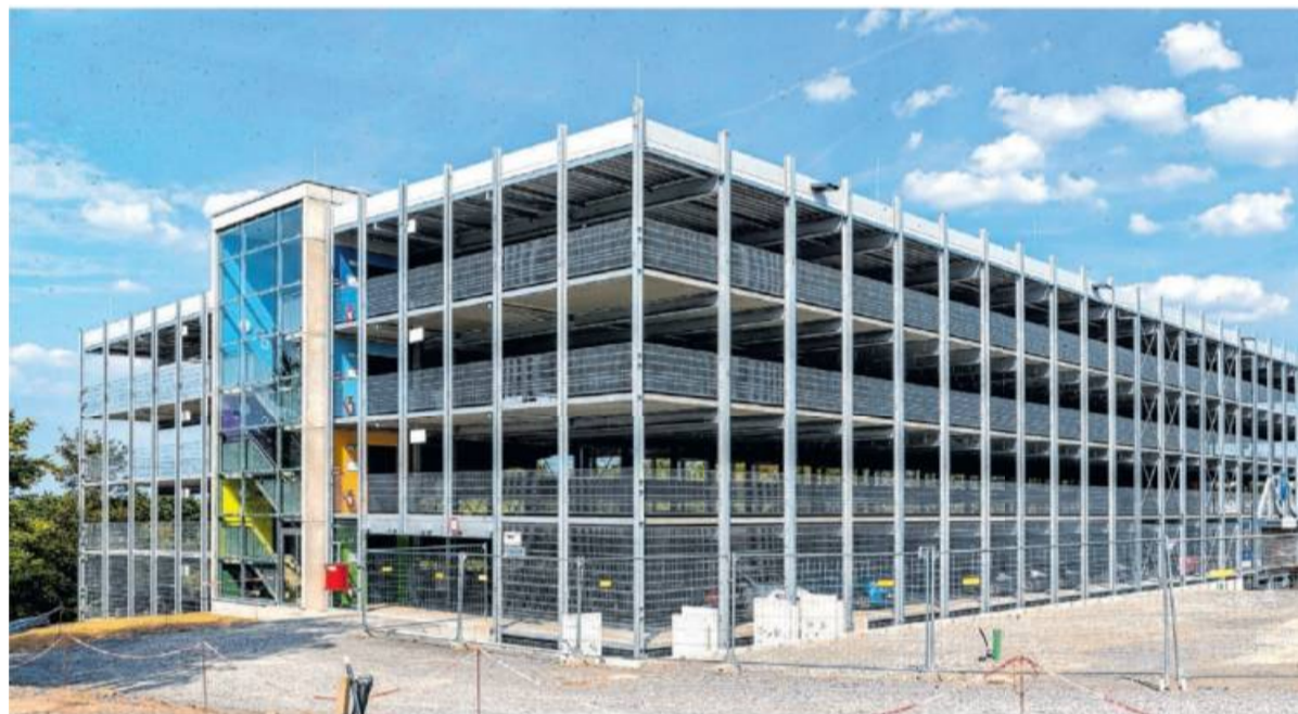
Die Etagen sind für Fußgänger über Treppenhäuser zu erreichen, ein Aufzug kann nachträglich eingebaut werden.
