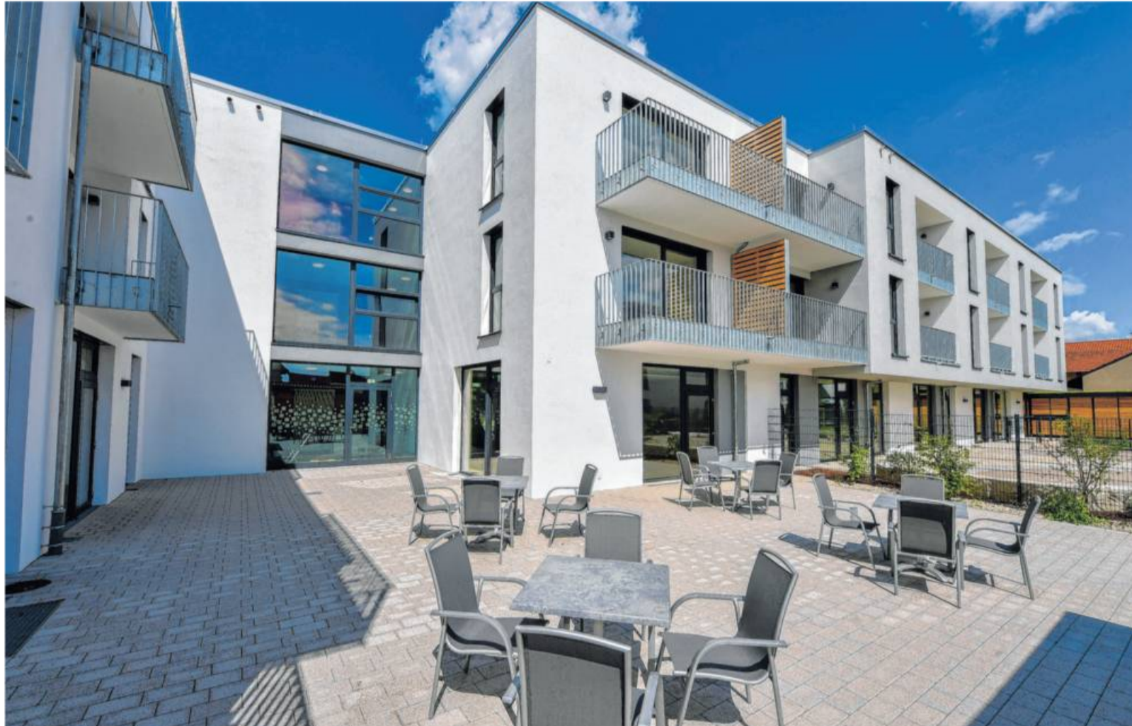
Die „WohnenPlus Residenz“ ist auf dem ehemaligen Cramer-Wanner-Gelände entstanden.
