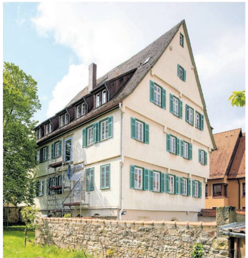
Das Amtsgericht Besigheim fährt den Dienstbetrieb wieder hoch (unser Archivbild zeigt das Gebäude im Jahr 2017, als sich die Außentreppe noch im Bau befand).
