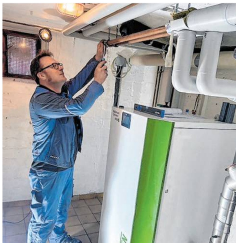
Im Keller arbeitet der Heizungsfachmann alleine, deshalb besteht bei Einbau der neuen Heizung keine Infektionsgefahr. Foto: tdx/ÖkoFEN (tdx)
