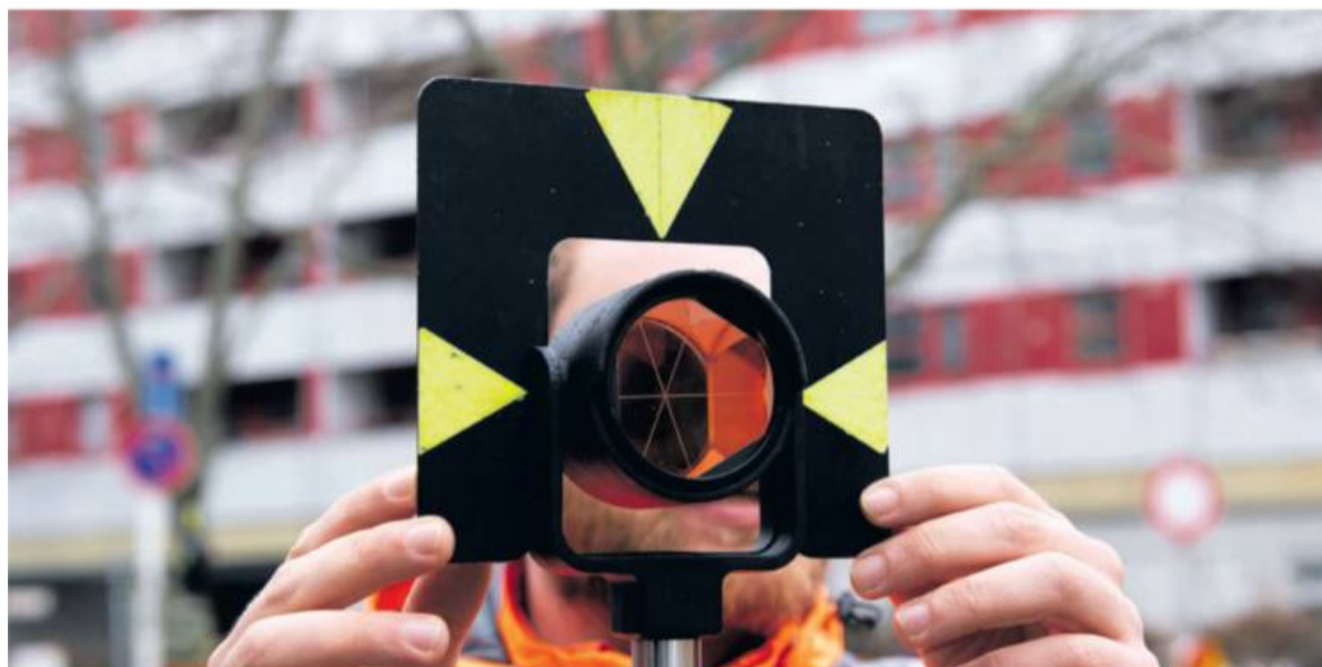
Vorbereitung für die Baustelle: Vermessungstechniker bestimmen Lage, Neigung und Höhe eines Grundstücks. Mit den Daten zeigen sie an, wo Grundstück gebaut werden soll. Foto: Catherine Waibel/dpa-tmn-
