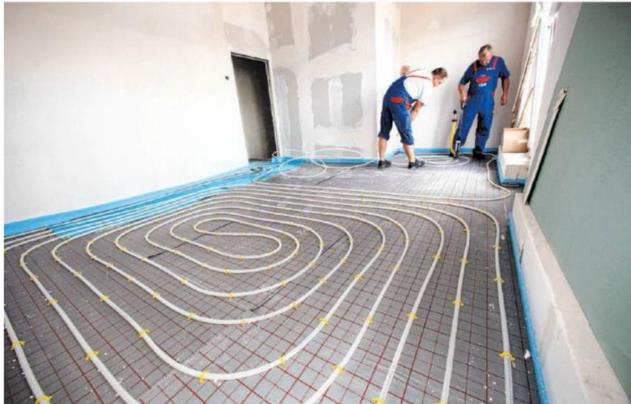
Fußbodenheizsysteme sind übliche Heizungen, durch deren Rohre Wasser fließt. Doch ihre Installation aufwendiger als die einer elektrischen Heizung. *Foto: Nestor Bachmann/dpa*
