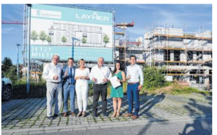
Frank Breckwoldt, Philipp Layher, Beata Breckwoldt, Dr. med. Jörg Bubeck, Lisa Davies, Daniel Rohrbach (v.l.n.r.) vor dem im Bau befindlichen neuen Gesundheitszentrum.
